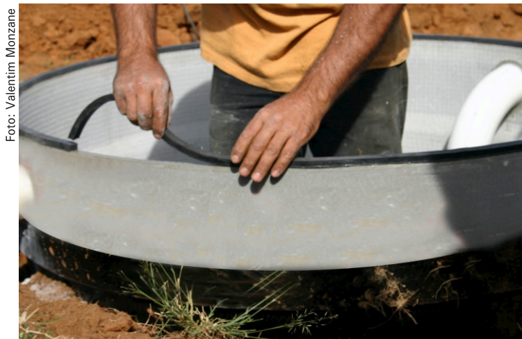
Figura 4. Vedação das caixas da Fossa Séptica Biodigestora com borracha macia.
