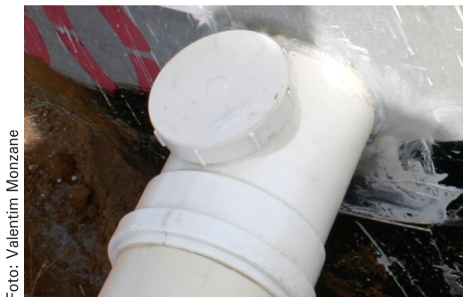
Figura 5. “Tê” de inspeção.
