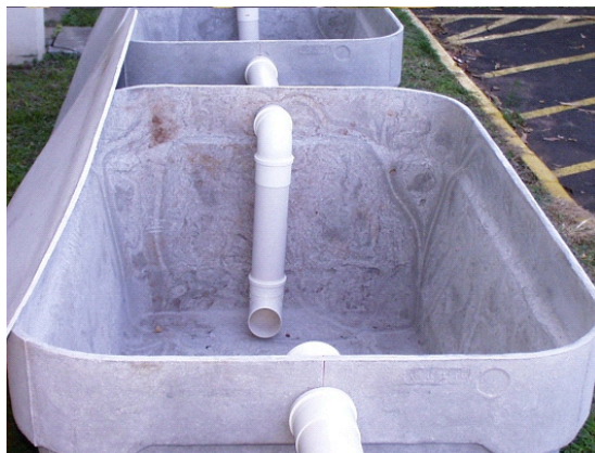
Figura 3. Detalhe de como colocar a tubulação nas caixas da Fossa Séptica Biodigestora.
